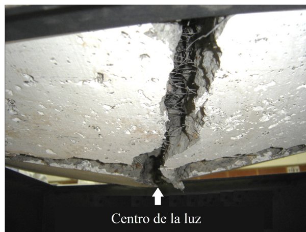
Figura 7. Cara inferior de la losa.
