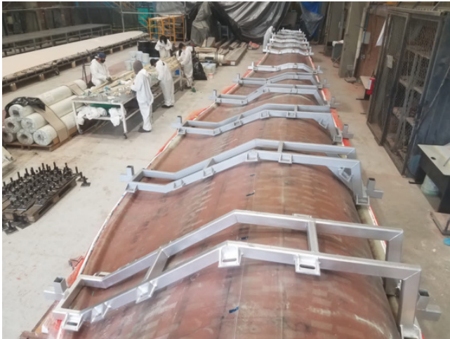
Figura 16 – Estructuras de 1er nivel colocadas sobre la pieza de material compuesto.
