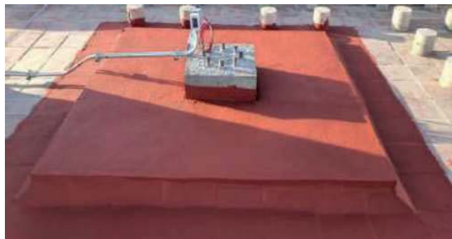
Figura 25. Soporte-chasis para la instalación del aerogenerador
