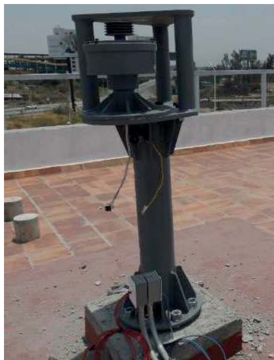
Figura 30. Montaje de la torre y el generador eléctrico
