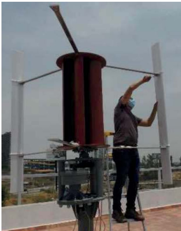
Figura 32. Montaje del rotor Savonius y Darrieus
