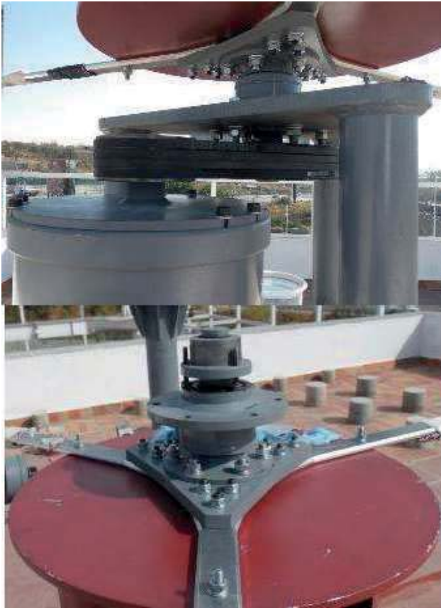
Figura 31. Montaje del tren de potencia
