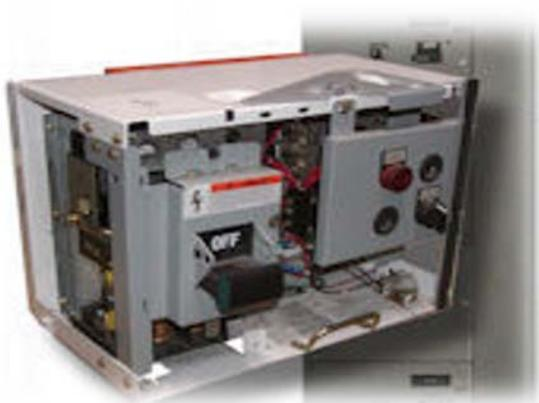
Figura 5. Controlador de motores.
